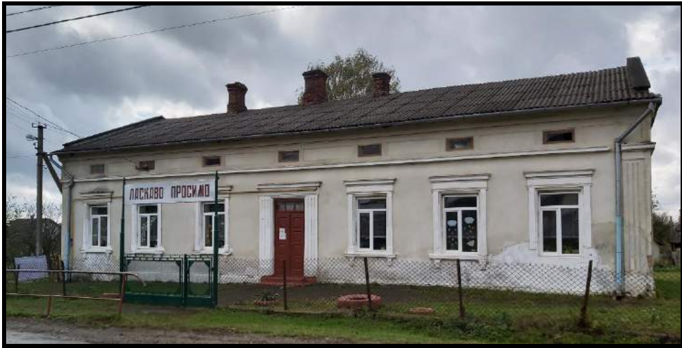
Fot. 143. Budynek szkoły. Stan na 2020 r.
