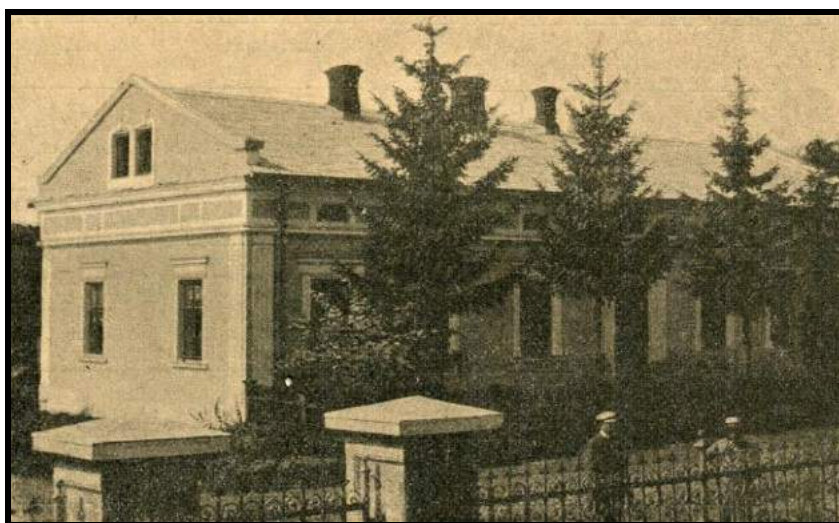
Fot. 13. Szkoła ewangelicka w Gelsendorf. Stan na 1895 r.
