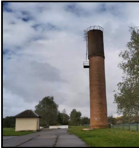
Fot. 118. Zabudowa przemysłowa. Stan na 2020 r.
