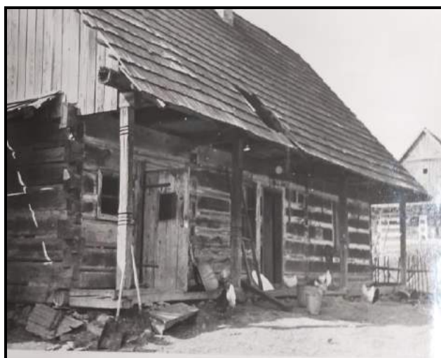
Fot. 8. Drewniany dom kolonisty w Bandrowie Kolonia. Stan na 1964.
