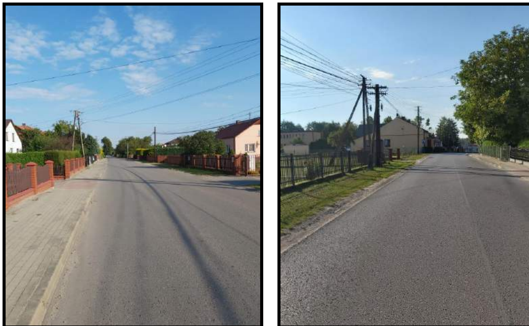
Fot. 78-79. Współczesna struktura przestrzenna ulicówki dwustronnie zabudowanej. Stan na 2020 r.
