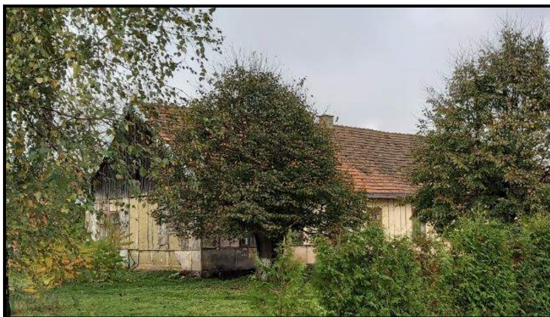
Fot. 114. Budynek dawnej szkoły. Obecnie biblioteka. Stan na 2020 r.
