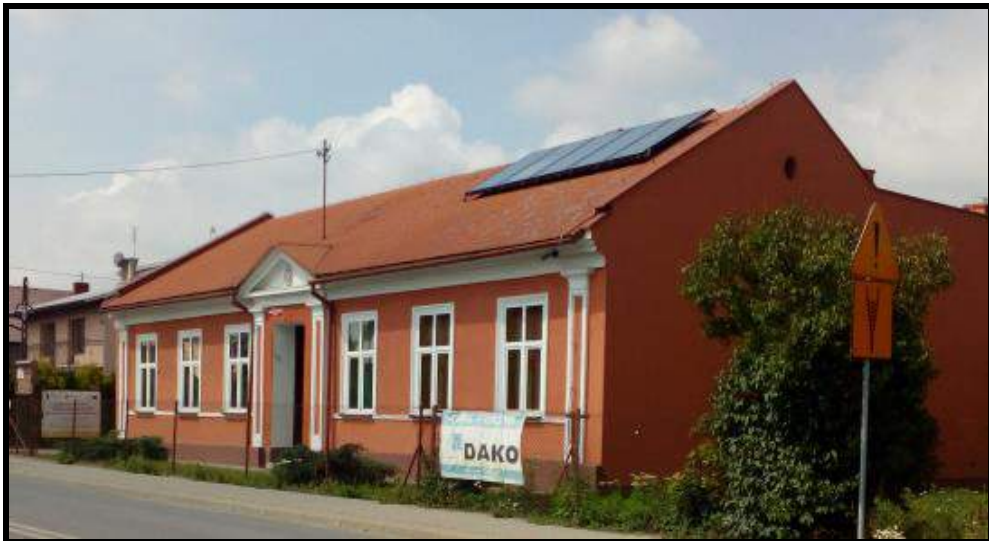
Fot. 93. Dawny budynek szkoły ewangelickiej. Stan na 2018 r.
