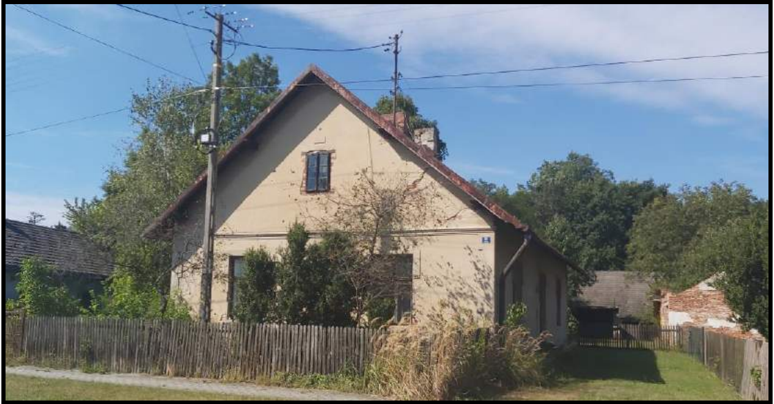
Fot. 65. Opuszczona zagroda niemiecka. Stan na 2020 r.
