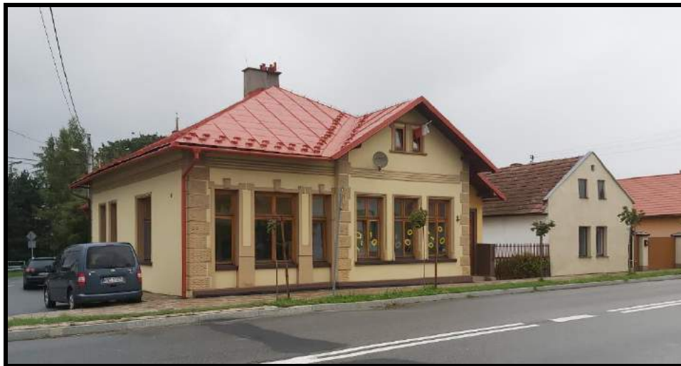
Fot. 51. Budynek dawnej szkoły, współcześnie przedszkole. Stan na 2020 r.
