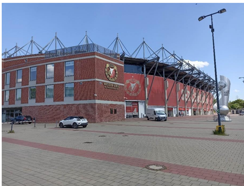
Fot. 5. Stadion Miejski Widzewa Łódź (stan na maj 2023) Autor: Bartłomiej Łuć
