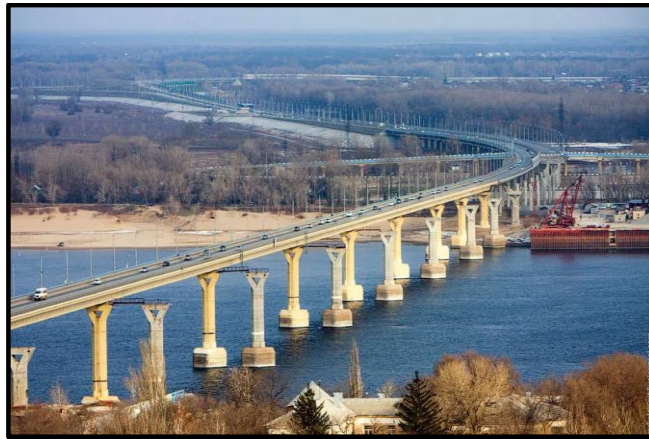
RYS.II.4.4.2.1. Widok "tańczącego" mostu w Wołgogradzie [106].
